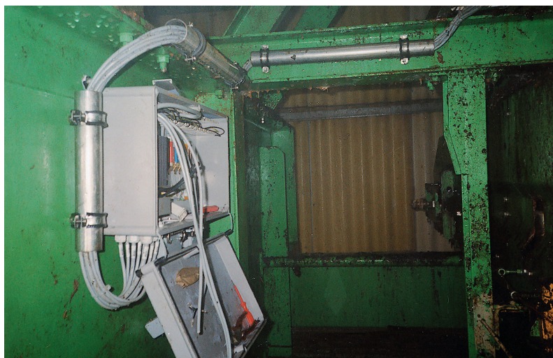
Прокладка кабеля в компостной установке
